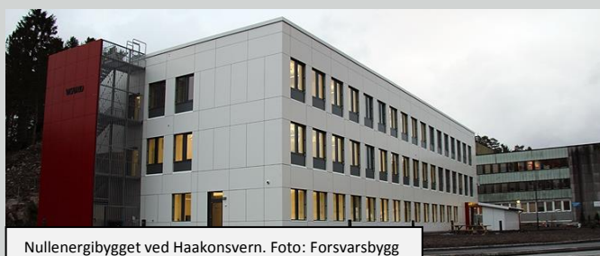
Nullenergibygget ved Haakonvern. Foto: Forsvarsbygg
