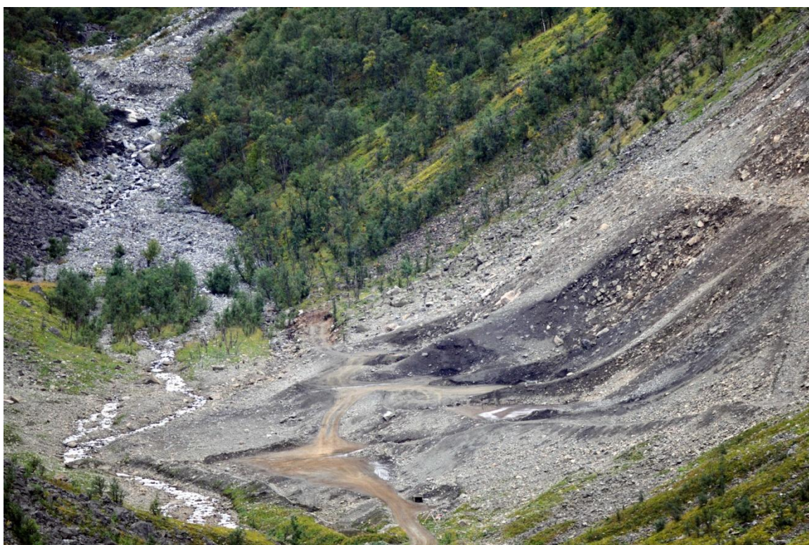
Figur 1.1 Demoleringsområdet i Øyradalen.
