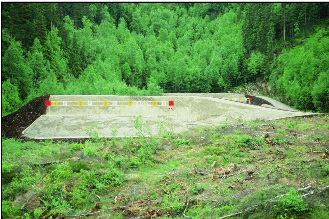
Figur 5.3 Bildet viser to nye fangvoller på Fuglemyr skytebane i Hurum kommune. Disse banene er bedre konstruert med tanke på tungmetallavrenning sammenlignet med bane c i Avgrunnsdalen
