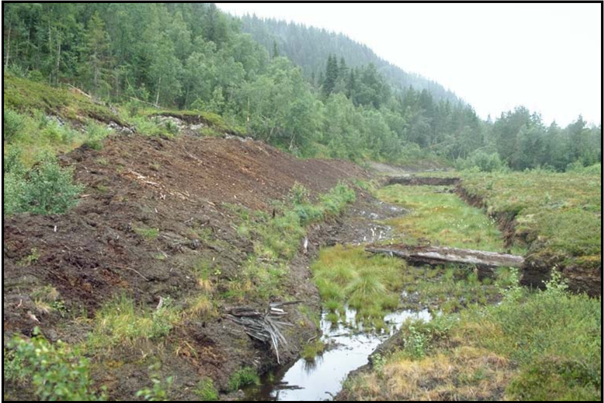
Figur 5.16 Fangvollen som ligger omtrent 100 m bak målområdet. Sigevannet fra vollen renner ut foran vollen og ut i dreneringskanalen hvor det ble målt høye tungmetallkonsentrasjoner
