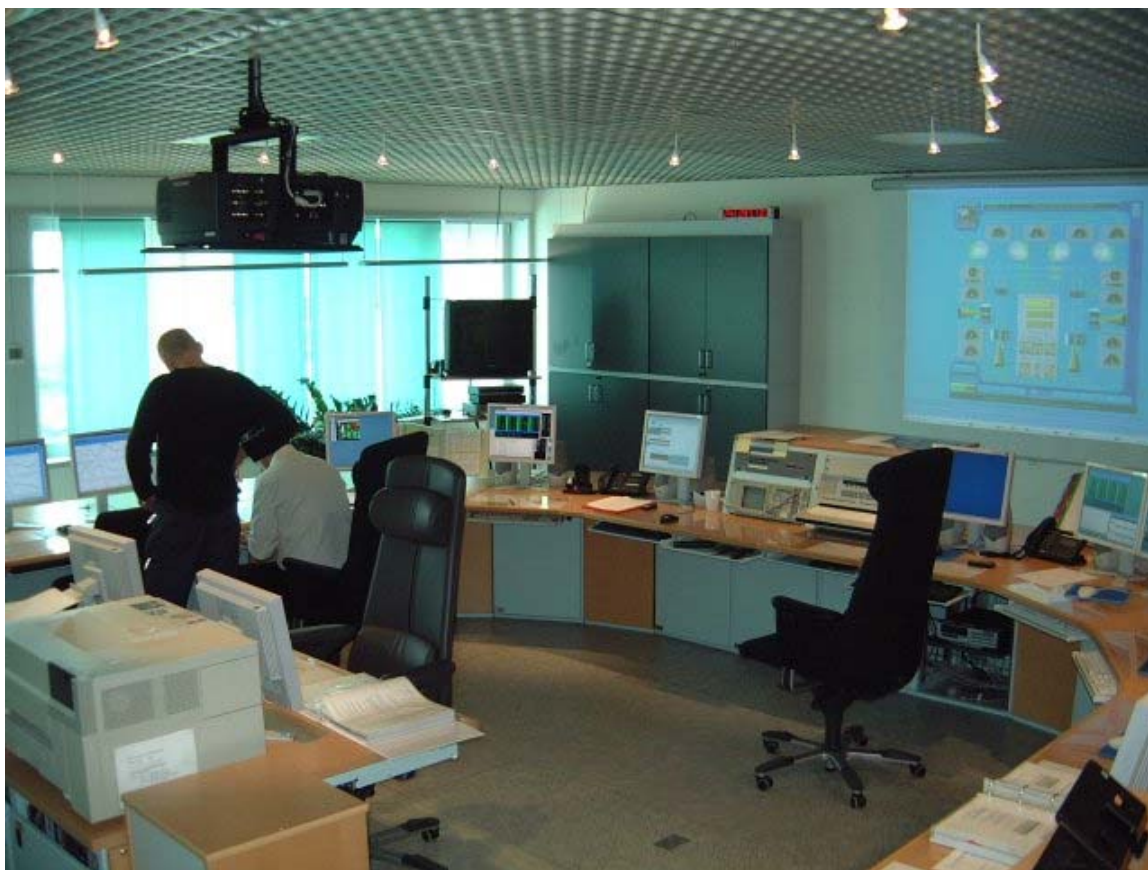
Figur 2.5 Kontrollrommet til Telenor på Fornebu. Herfra opereres Thor II og Thor III (6)
