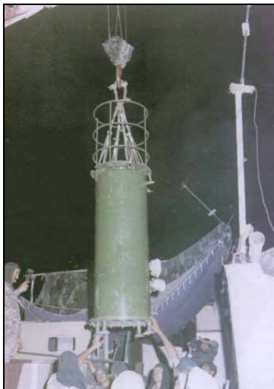
Figur 4-6 Her ser vi én av de indiske kjernefysiske ladningene fra Shakti-98, idet den blir senket ned i sjakten. Bildet er hentet fra Sublette (26), som antar at det er den termonukleære ladningen som vises frem.
