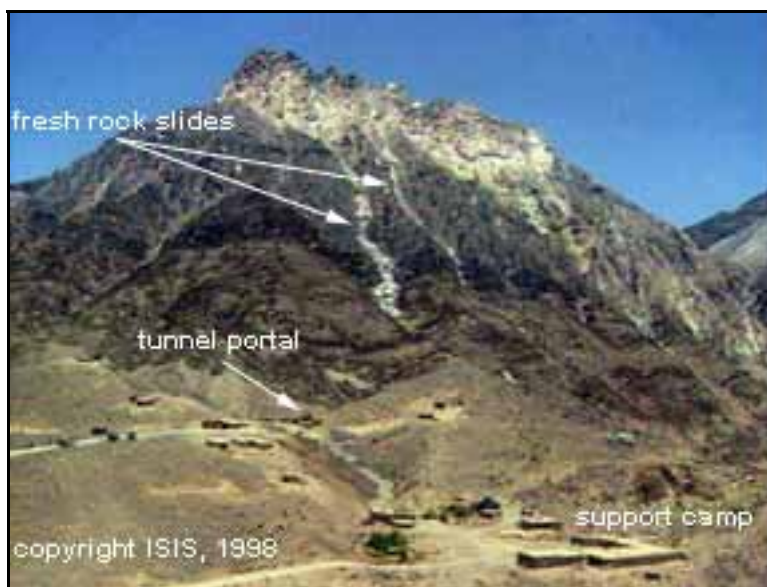
Figur 5-5 Fjellet der Chagai-1 ble detonert. Her ser man hvordan tunnelen er arrangert. Bildet skal være hentet fra pakistansk TV, mens kommentarene er påskrevet av Institute for Science and International Security og F Pabian. Hentet fra Institute for Science and International Security (67).
