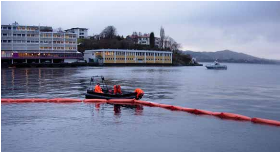
Figur 2.3 Utsetting av oljelense med presenningsskjørt utenfor de gjenfylte dokkene ved ubåtbunkeren i Laksevåg
