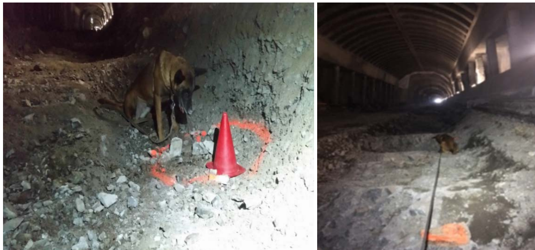
Figur 4.8 Høgenheitunnelen i Bamble.
