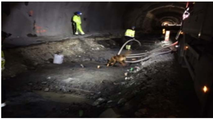
Figur 4.15 Søk i Høgenheitunnelen.
