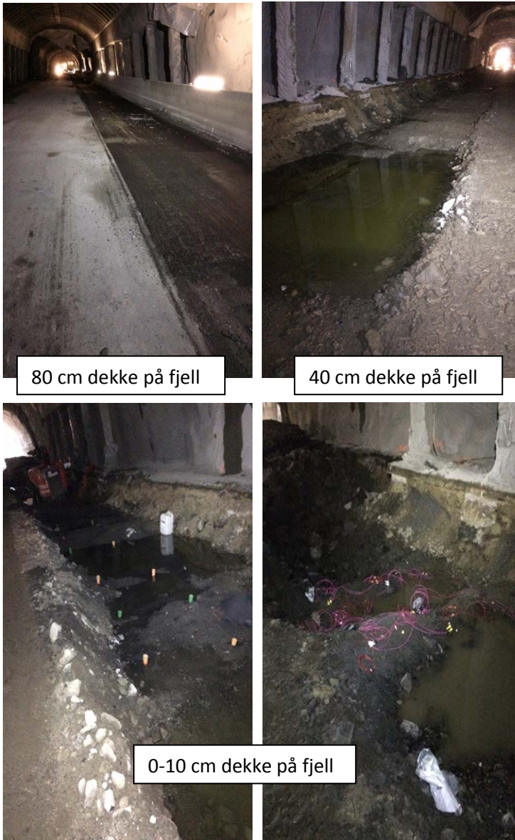
Figur 4.14 Eksempel på sanering i henhold til prosedyre.
