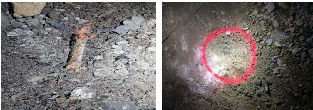
Figur 4.16 Funn av dynamitt i Høgenheitunnelen.
