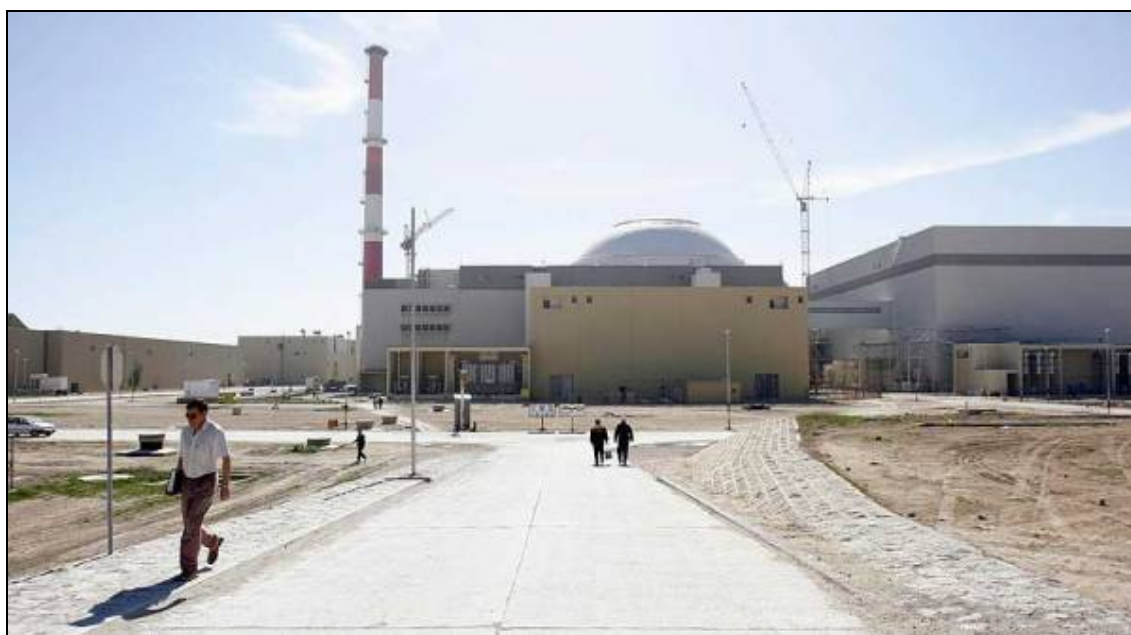
Figur 3.2 Bilde av det uferdige kjernekraftverket i Bushehr vinteren 2006. (Foto: Raheb Homavandi / Reuters)
