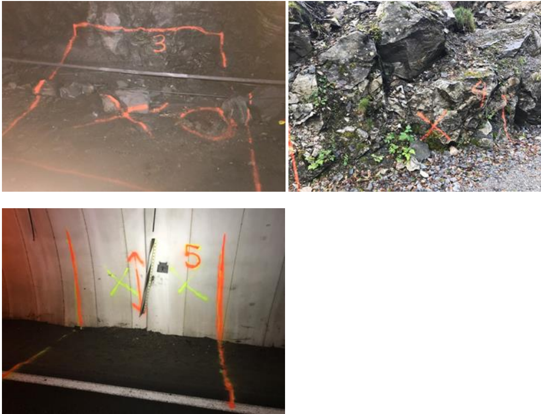
Figur 2.14 Søk i Vågstunnelen
