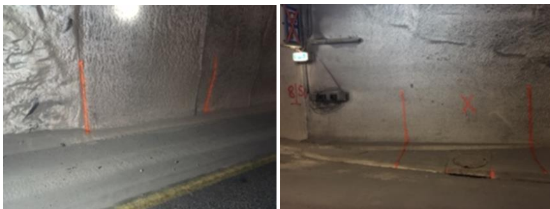
Figur 2.6 Søk i Lyderhorntunnelen
