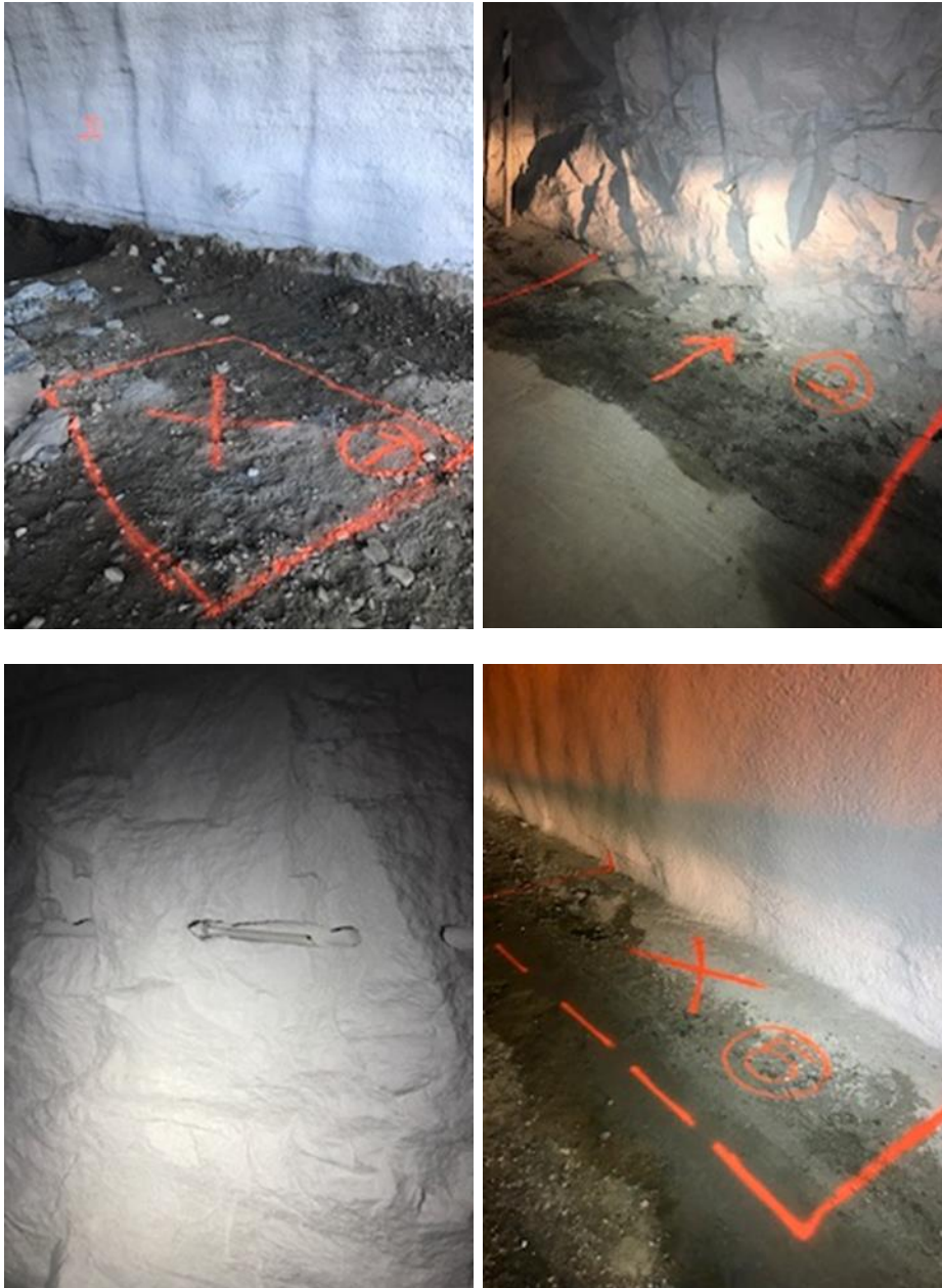
Figur 2.13 Søk i Bjørgatunnelen
