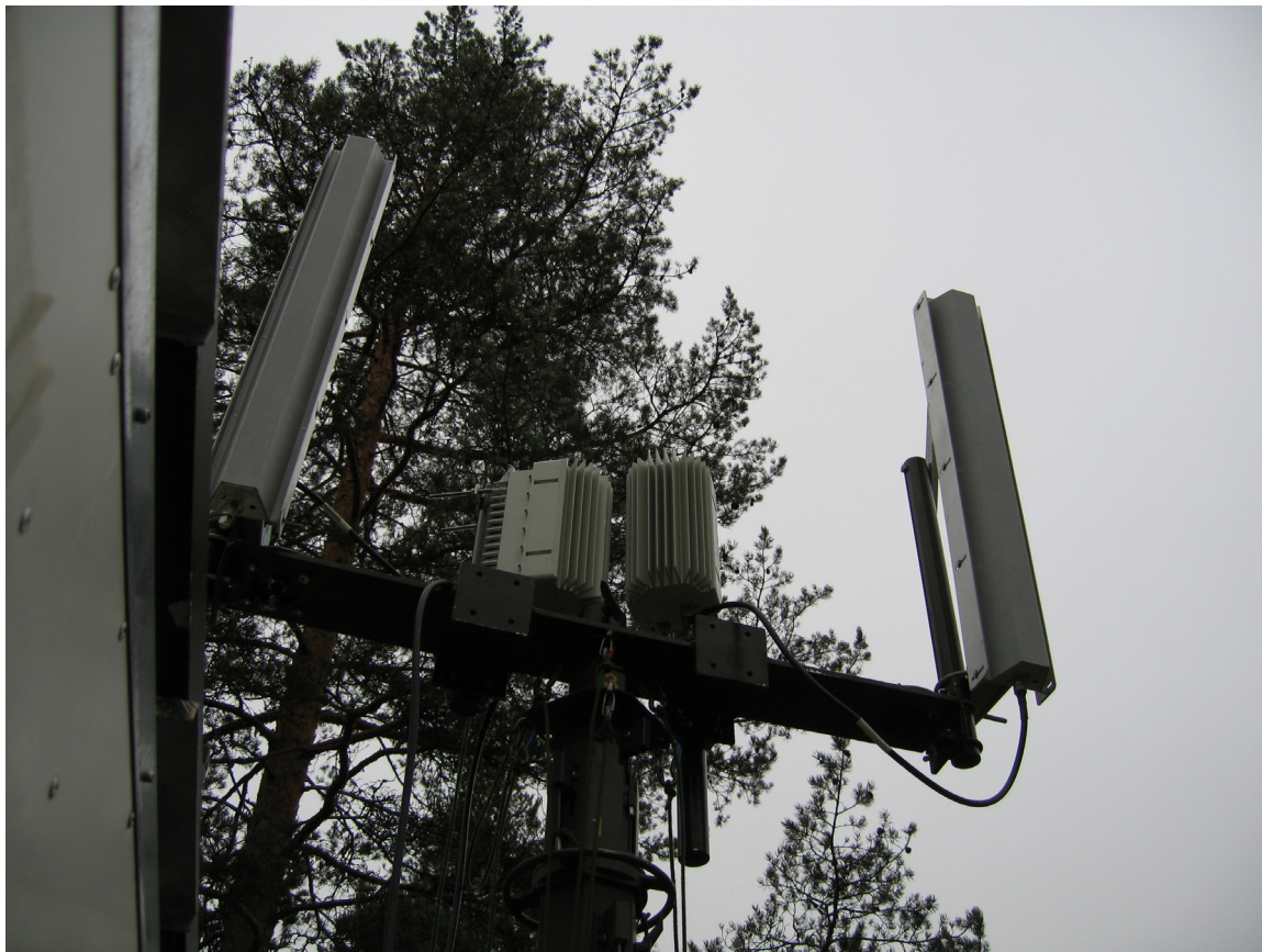
Figur 2.3 Sektorantenner. Hver antenne har sin egen ODU.
