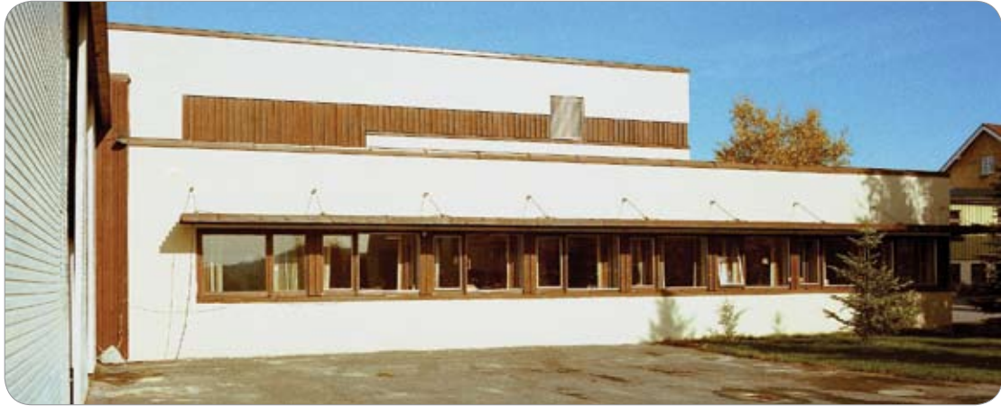
Det nye Fellesverkstedet ble innviet 14. april 1977.
