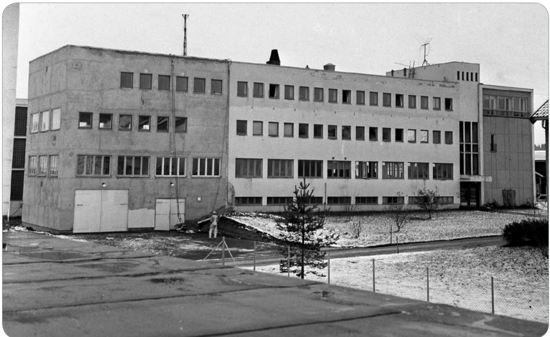
Fellesverkstedet 1961 etter forlengelsen.
