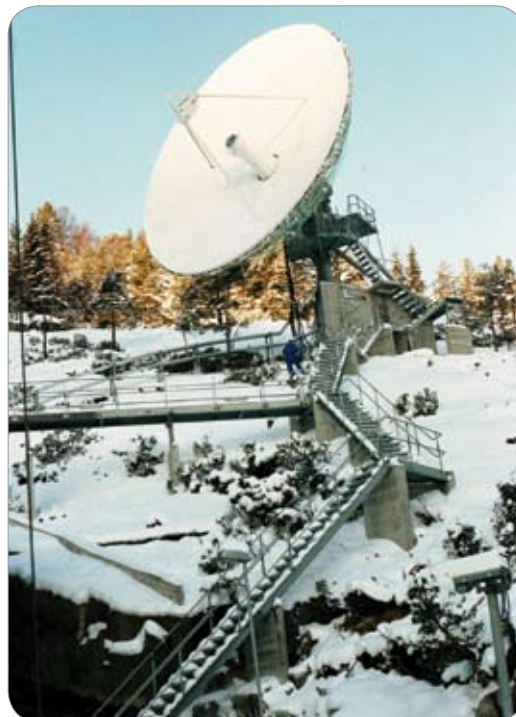
Parabolantenne, 12 m diameter, fremstilt ved Fv og plassert på Eik jordstasjon.
