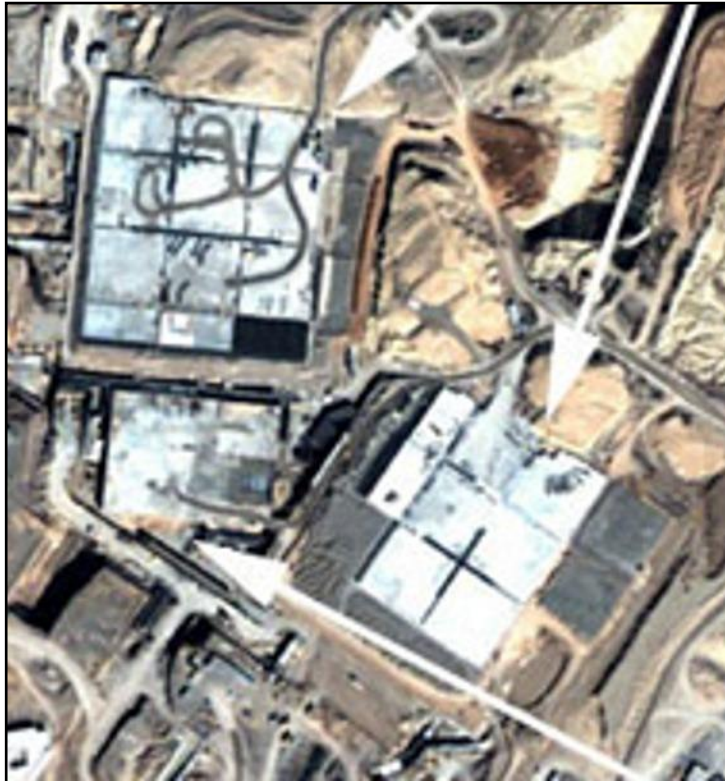
Figur 6.2 Satellittbilde fra februar 2003 som viser inndelingen av de to produksjonshallene i Fuel Enrichment Plant (FEP) i moduler. (Tilpasset fra bilde fra ISIS / Digital Globe.)
