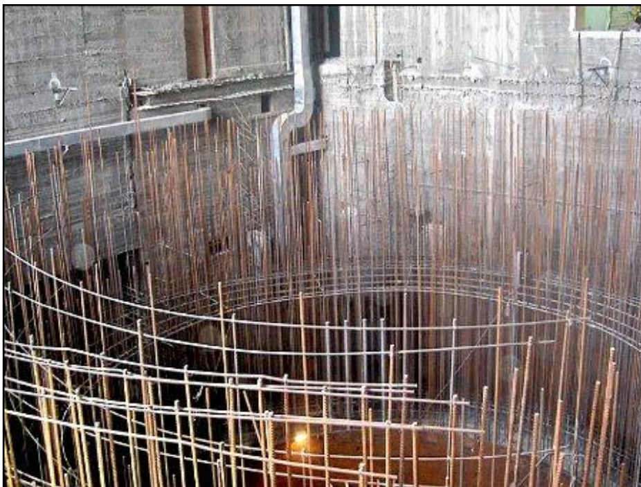
Figur 7.6 Armeringen til det biologiske skjoldet til den angivelige reaktoren i Dair Alzour. (Scanpix - AP Photo - CIA)
