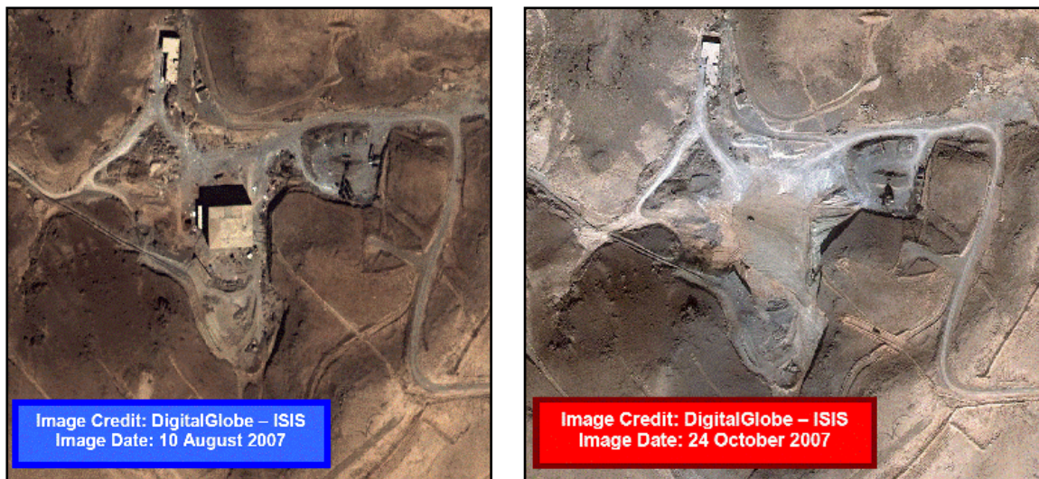
Figur 7.3 Den mistenkte reaktorbygningen før og etter flyangrepet. Støttebygningen står urørt av angrepet. (Bilderettigheter: DigitalGlobe og ISIS.)
