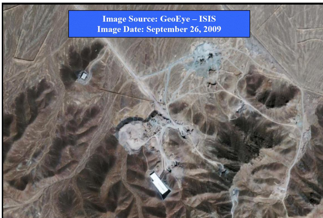
Figur 6.6 Satellittbilde av Fordow urananrikningsanlegg. (Fra GeoEye og ISIS.)
