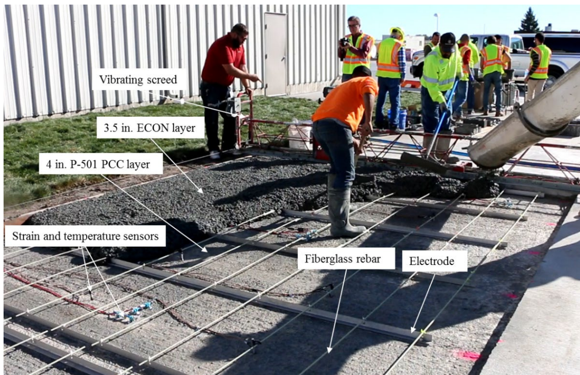
Figur 7.2 Konstruksjon av «Electrical Conductive Concrete» (ECON) på Des Moines International Airport, bilde fra (Abdualla et al., 2018a).
