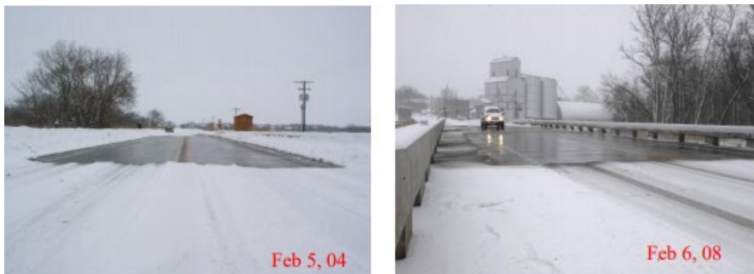
Figur 7.3 Bilder fra Roca Bridge med avising ved hjelp av «electrical conductive concrete», bilde fra rapport av Tuan (2008).
