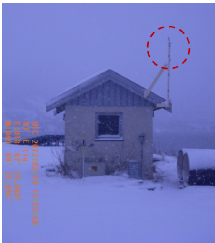
Figur 2.5 Værstasjon (WS-2355) montert på taket av bod på NATO-kaia i Sørreisa.
