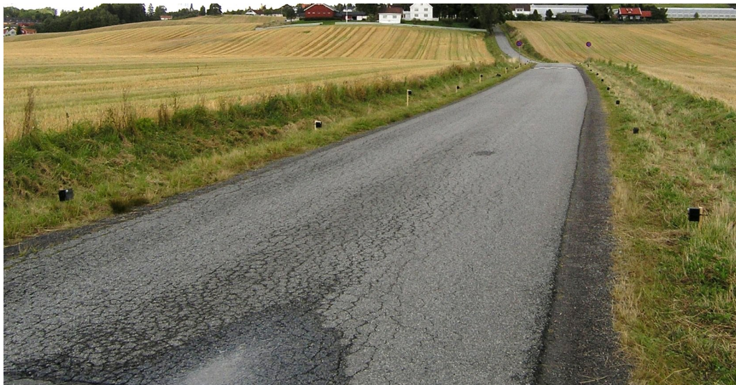
Figur 4.1 Akseovervåkning av en 190m lang veiakse. 40 sensornoder med radar, IR og akustisk sensor utplassert.
